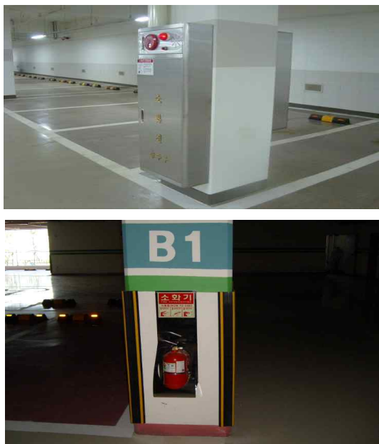
기존 옥내소화전함 및 소화기 설치 이미지
