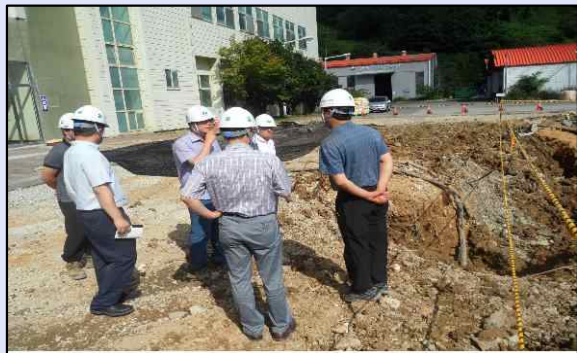
<대형 건설공사장 민·관 합동 점검 전경>
