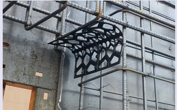
《응력분산곡면판 설치 모습》
