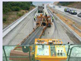
<철근 연결 및 시점부 콘크리트 포설>
