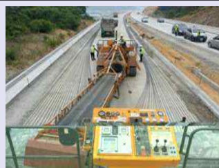
<철근 연결 및 시점부 콘크리트 포설>
