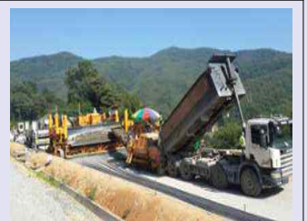
<철근배근 동시 콘크리트 포설>
