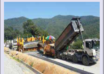
<철근배근 동시 콘크리트 포설>
